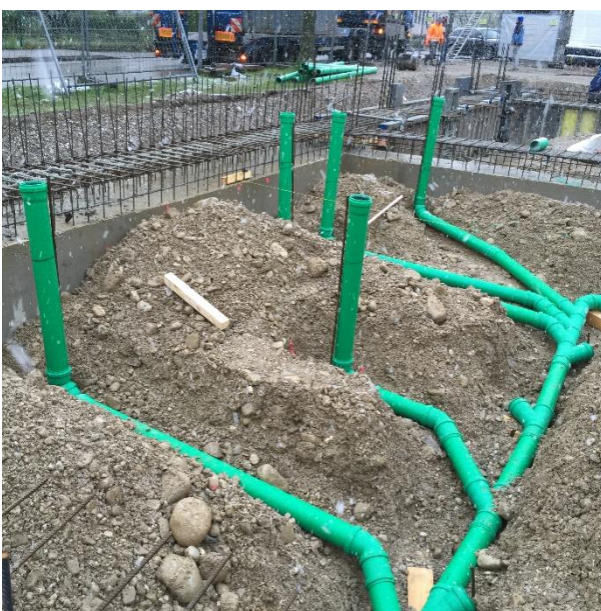
Grundleitungen Bereich Küche
